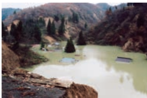
▲水没した木籠集落 山古志地域木籠集落には、中越大地震により水没した家屋が残っている。地震により地滑りが起き、川が堰き止められ、集落の約半分が水没した。
