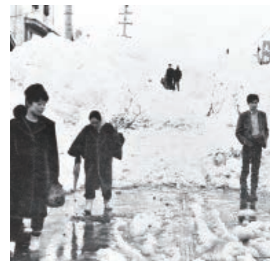
▲威力を発揮する消雪パイプ 36豪雪後に敷設され、38豪雪で大活躍した。
