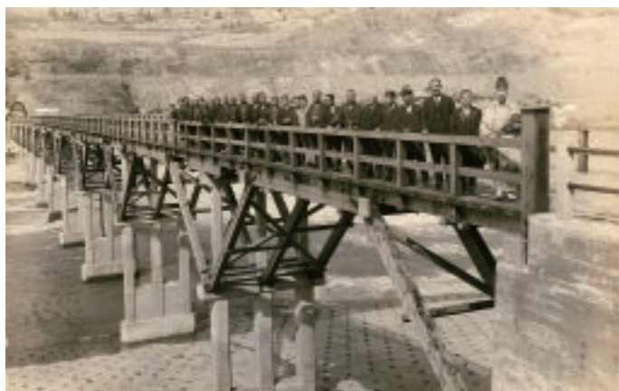
▲野積橋竣工渡り初め（長岡市立科学博物館所蔵） 昭和6年（1931）竣工。大河津分水路開削に伴う最初の架橋となった。
