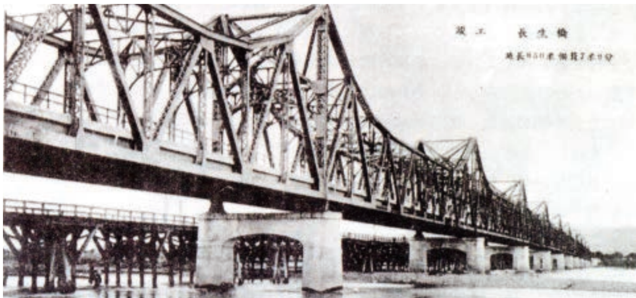
▲手前に鉄橋となった長生橋と奥に木橋が見える（長岡戦災資料館所蔵） 鉄橋化された3代目長生橋は昭和9年（1934）1月着工、12年10月完成。全長約850m、幅7mで、鉄骨を交互に組み合わせた13連トラスが特徴である。
