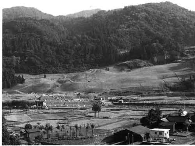
着々と工事が進むふるさと交流広場
