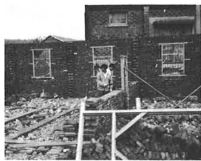
▲家屋の建築現場
