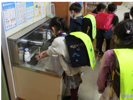
〈温水設備で手洗い〉
