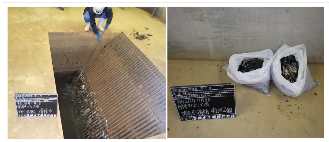
写真 2.3 関東町ポンプ場スクリーンの状況
