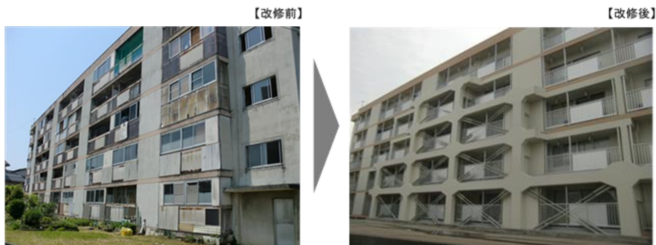
図 2-3-4-16 ≪市営住宅の耐震改修例（昭和団地）≫
