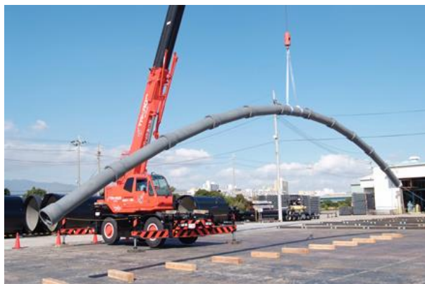
図 2-3-5-21 <<耐震化で使用する耐震管の例>>
