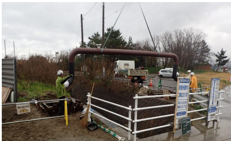
図 2-3-5-19 《管路の耐震化の例》
