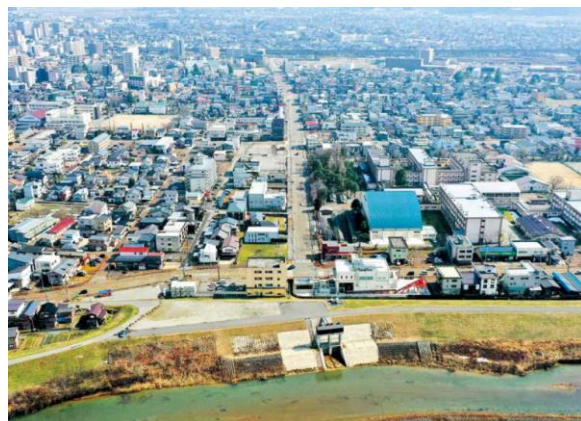
図 2-3-5-10 《都市雨水対策の強化を図る 柿川放水路の整備》
