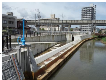
放水路の整備(柿川)
