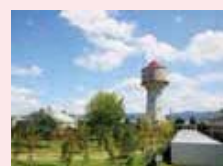
ランドマークとなっている水道タンク
