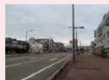
電線類が地中化された道路
