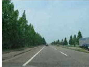
街路樹が連続した国道8号（長岡）
