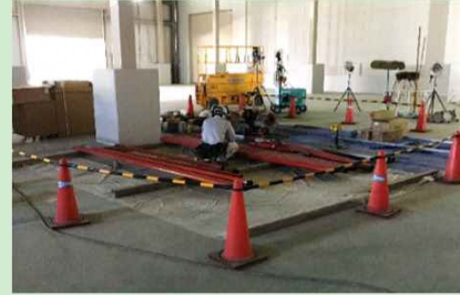
工事エリアの区画を設定して作業
