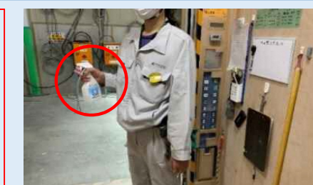
EVの操作盤等の消毒を徹底
