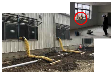
送風機を稼働し、埃を外部へ排出
