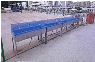
現場の手洗い場所の増設
