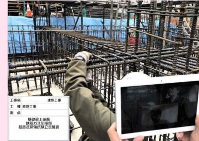
Webカメラを利用した遠隔検査
