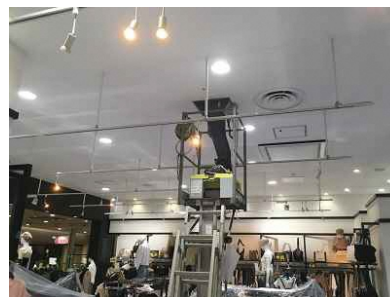
天井裏の作業は換気が難しいため、空間除菌剤を設置
