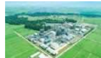
南長岡ガス田 越路原プラント
