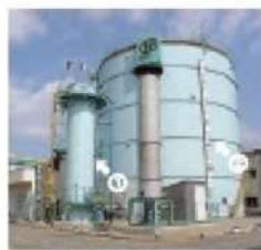
▲ガスを調製する①精製塔と②ガスホルダ
