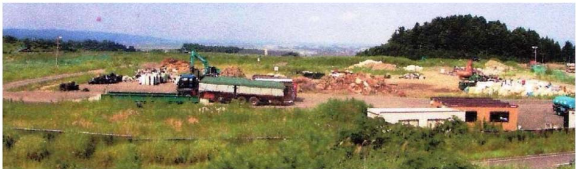
▲中越大震災：住宅廃材仮置場
