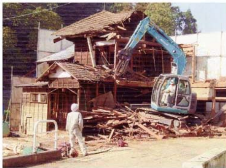
▲住宅解体現場
