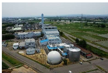
生ごみバイオガス発電センター
