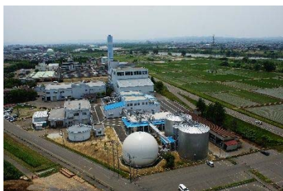
生ごみバイオガス発電センター
