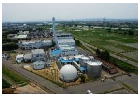
生ごみバイオガス発電センター
