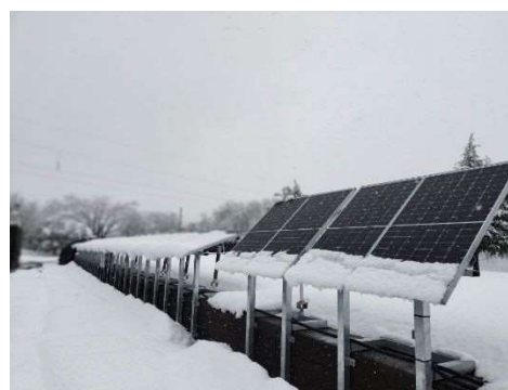
【中央浄化センター】
