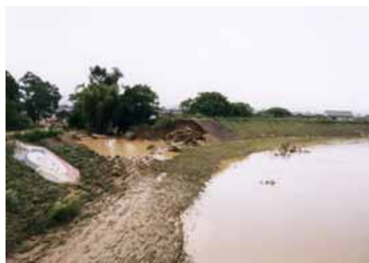
（破堤した刈谷田川）
