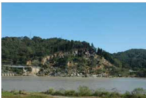
(長岡地域妙見「土砂崩落現場」)
