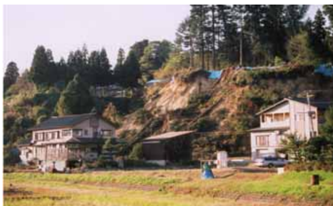
（がけ崩れ箇所）
