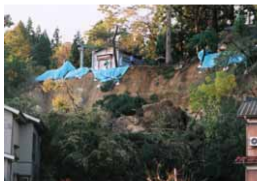
（がけ崩れ箇所）
