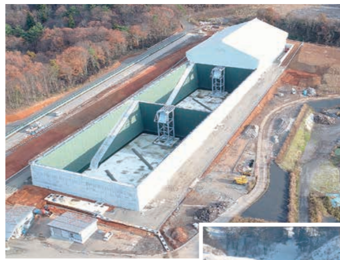
▲建設中の最終処分場。テント張りの屋根が付いています（昨年11月）
