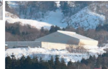
▲建設中の最終処分場。テント張りの屋根が付いています（昨年11月）
