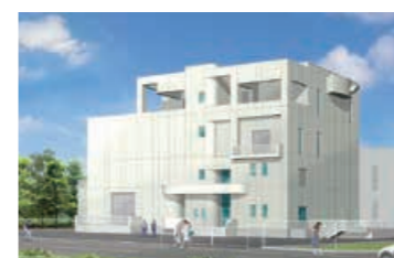
▲令和5年度に完成予定の寿町排水ポンプ場
