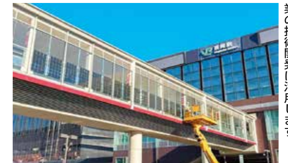
公共施設への設置が進む雪国対応型の太陽光パネル。再生可能エネルギーの普及や大学・企業の技術開発に活用します
