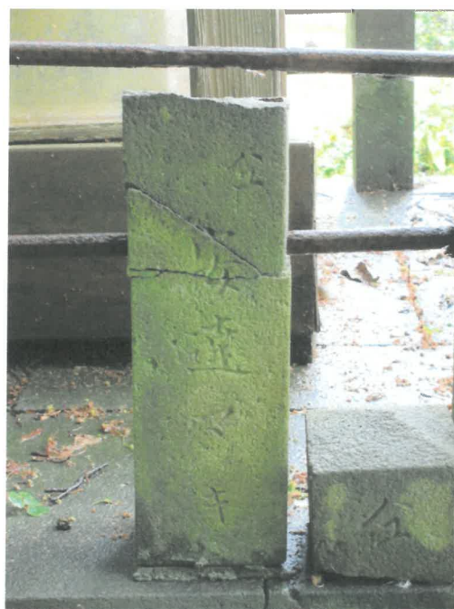
玉垣の破損状況(背面2)
