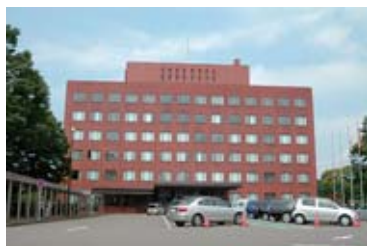
▲耐震性に不安を抱える本庁舎
