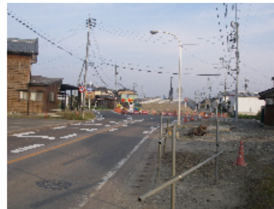
水害からの復興（道路整備）
