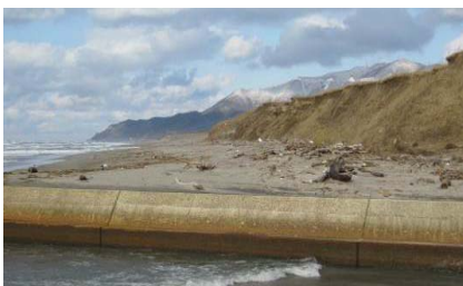
写真－新たな水上バイクエリアの現状
