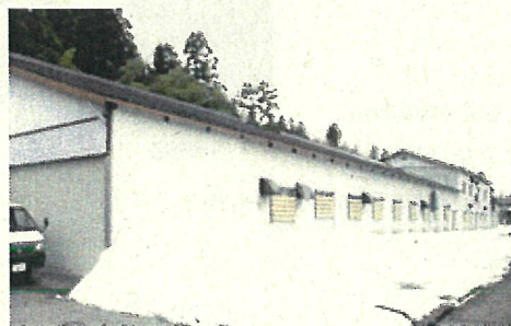
本社工場／新潟県長岡市
