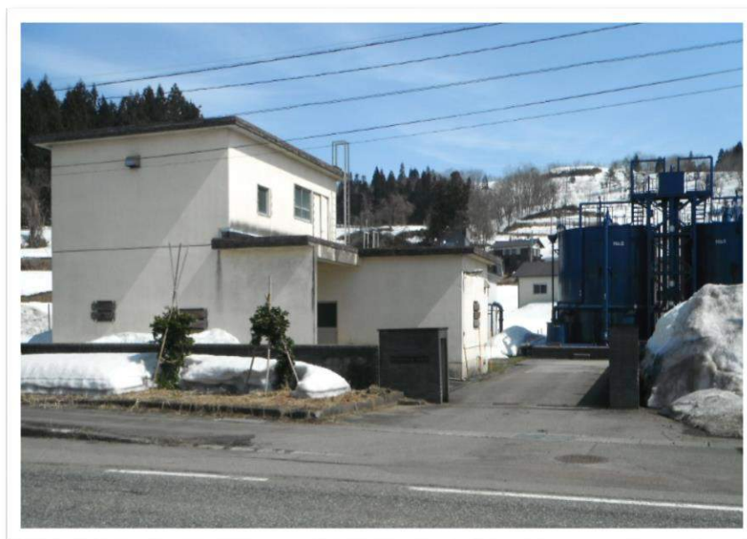
川口中央簡易水道 中山浄水場
