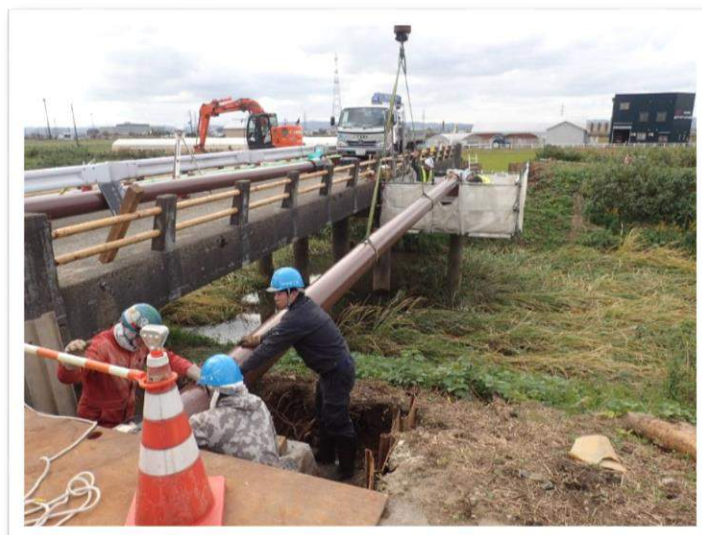
耐震管布設替工事
