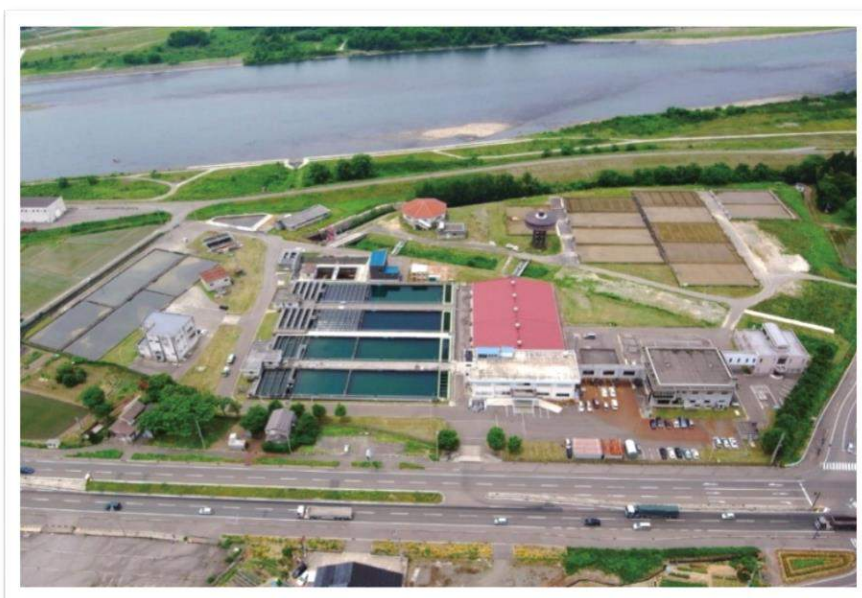
骨格送配水幹線施設の一つである妙見浄水場
