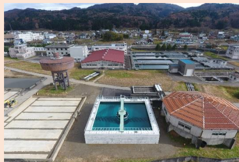
妙見浄水場濃縮槽築造工事（妙見町）
