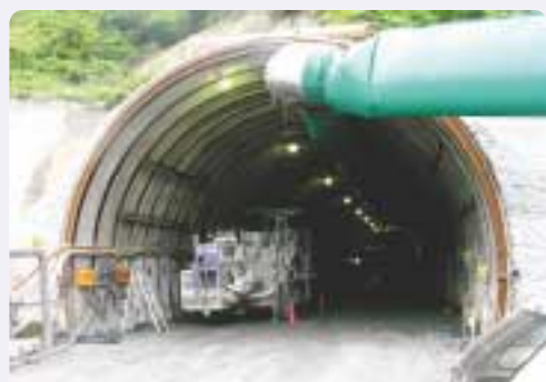
▲国道291号トンネル工事現場（17.8.25撮影）
