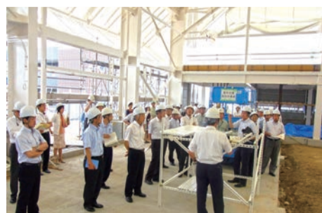
ニュータウン運動公園（屋根付多目的コート）
