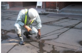
消雪パイプの点検
