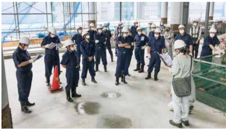
建設工事完了後のレイアウト等を確認（A-2街区）
