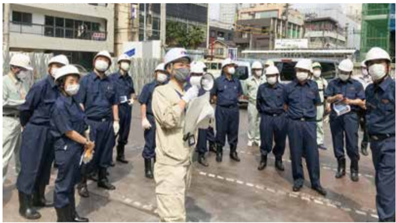
A-1街区の建設現場で進捗状況を確認
