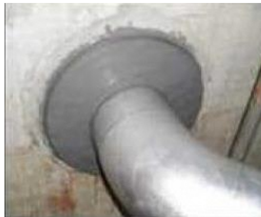
<止水処理(配管貫通部)>
