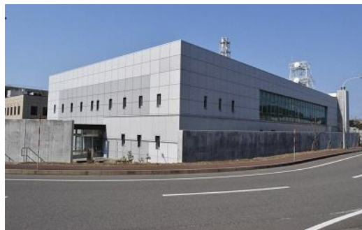
免震重要棟※(外観)
