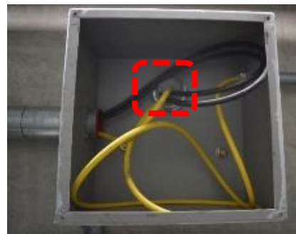
【個々の貫通部の確認】
