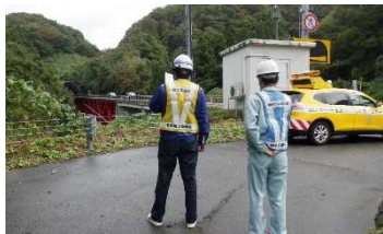
地震で被災した避難道路の啓開 (復旧)訓練を実施 (柏崎市)
