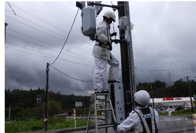
信号機の復旧
