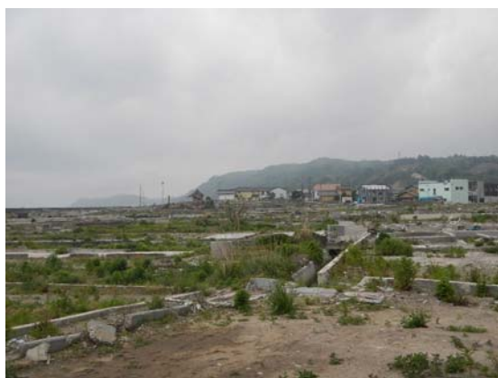
↑津波被害の状況
