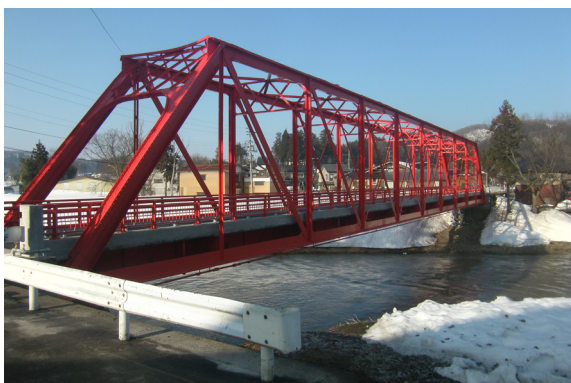
橋りょうの長寿命化の推進 (リニューアルした不動沢橋)
