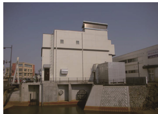
浸水被害の軽減に向けた下水道施設の整備 (西神田排水ポンプ場)
