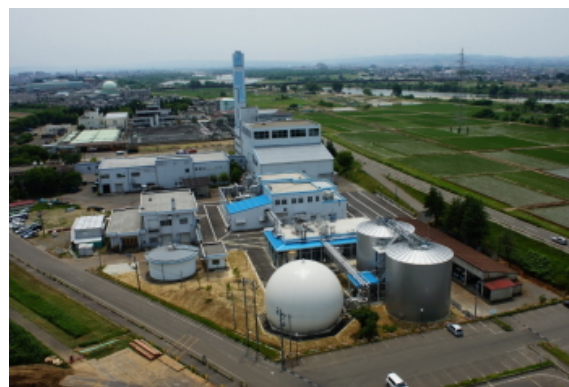
生ごみバイオガス発電センター
