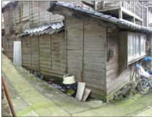
外壁が裸木造の例
