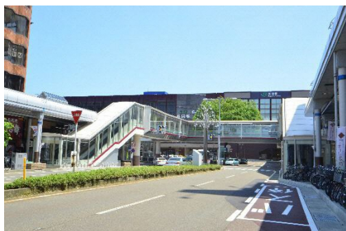
JR 長岡駅と中心市街地を結ぶ「大手スカイデッキ」
